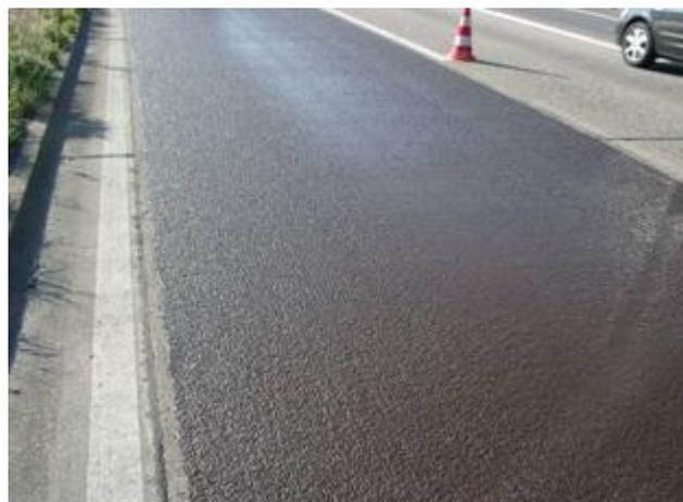
**Abbildung 4: Fahrstreifenbezogene Erhaltungsmaßnahme mit DSK im frischen Zustand**
