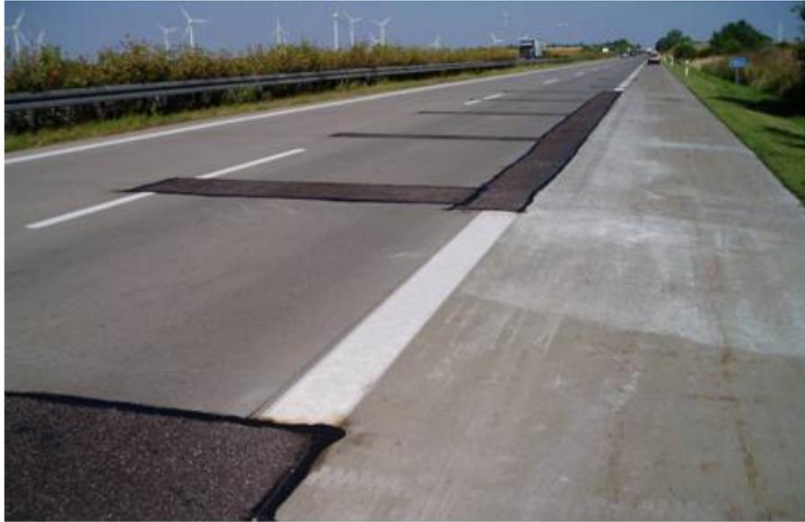
**Abbildung 6: Vorbereitete Betondecke mit instandgesetzten geschädigten Bereichen für eine Überbauung mit Walzasphalt <sup>1)</sup>**
