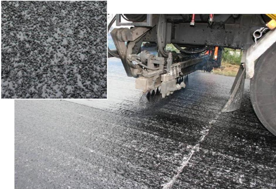
**Abbildung 5: Aufbringen der SAMI-Schicht mit Abstreuerung auf einer Haftbrücke**
