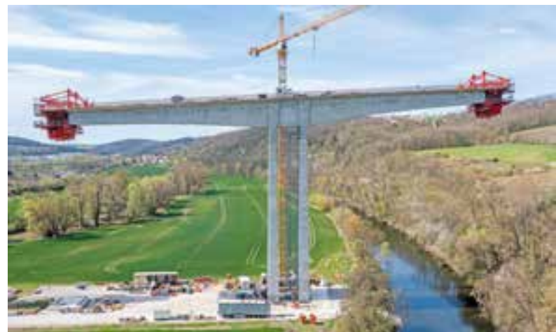
■ Freivorbau nach Waagebalkenprinzip © Peri Vertrieb Deutschland GmbH & Co. KG
