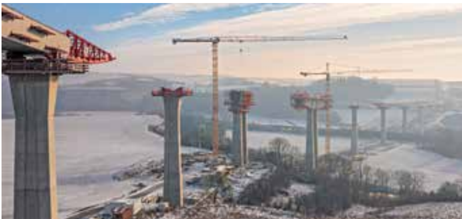
Hybridbauweise: Taktstiege- und Freivorbauverfahren © Peri Vertrieb Deutschland GmbH & Co. KG
