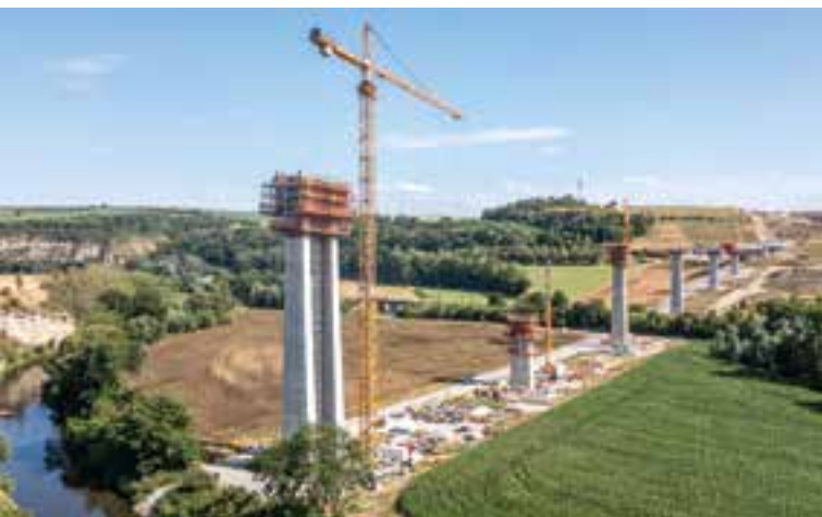
■ Doppelpfeiler an der Saale © Peri Vertrieb Deutschland GmbH & Co. KG
