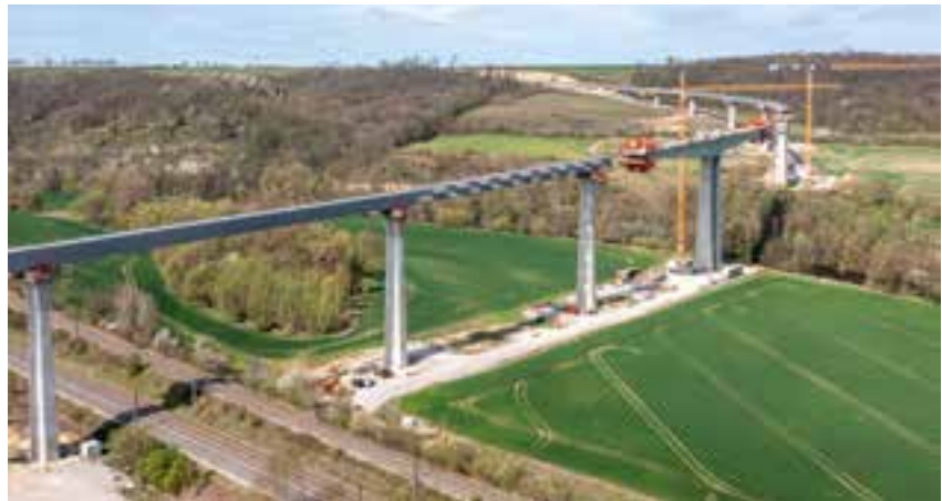
■ Querungsbauwerk im Landschaftsschutzgebiet © Peri Vertrieb Deutschland GmbH & Co. KG
